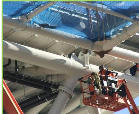
Şekil 18: Yükseltilebilir iş platformu aracılığıyla güvenlik ağı kurulumu
