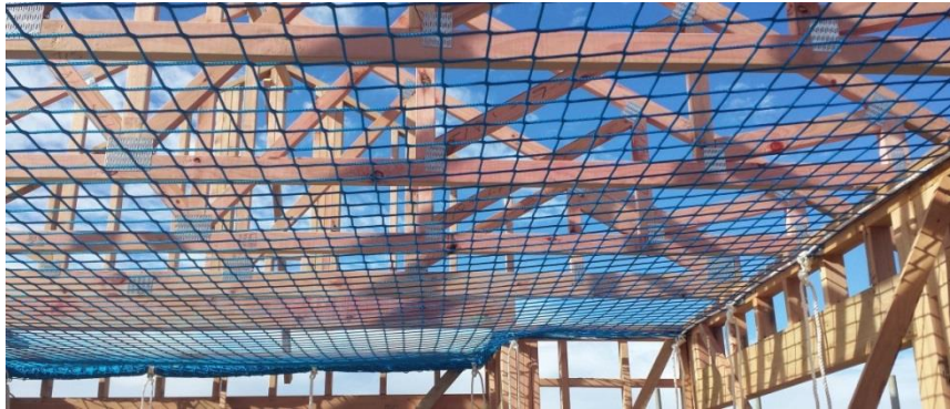
Şekil 15: Çatı işinde güvenlik ağı kullanımı
