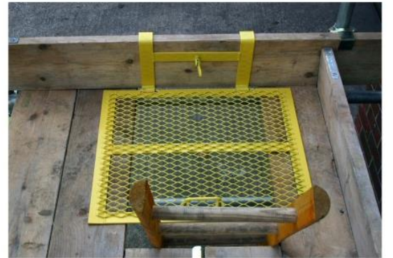
Şekil 23: Merdiven ulaşım açıklığı
