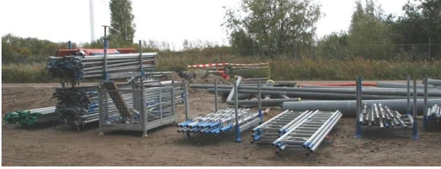
Şekil 12: Malzemelerin istiflenmesi
