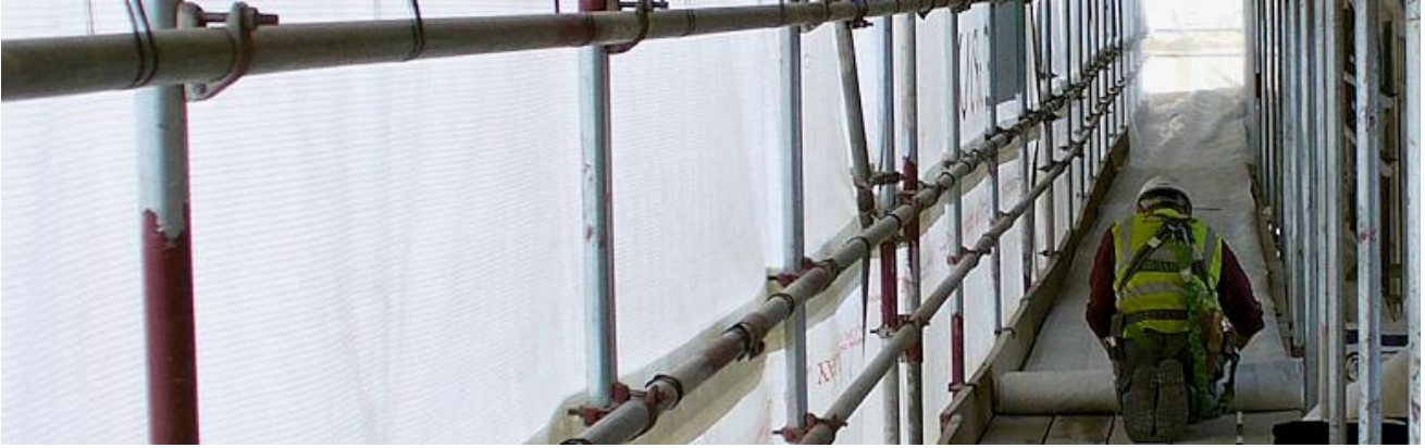
Şekil 40: İskelede kaplama yapılması
