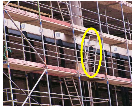
Şekil 8: İskele içi merdivenler
