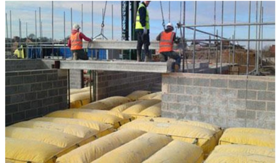
Şekil 3.14. Hava yastığı sisteminin bir inşaatta kullanımı [19]
