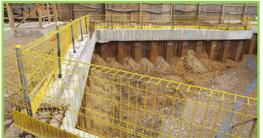
Şekil 5.6. Kazı kenarında düşmeye karşı koruma [33]
