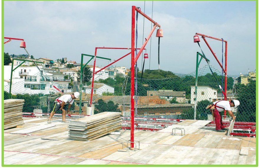
Şekil 5.4. İnşaat kalıp çalışmasında düşmeye karşı koruma [31]
